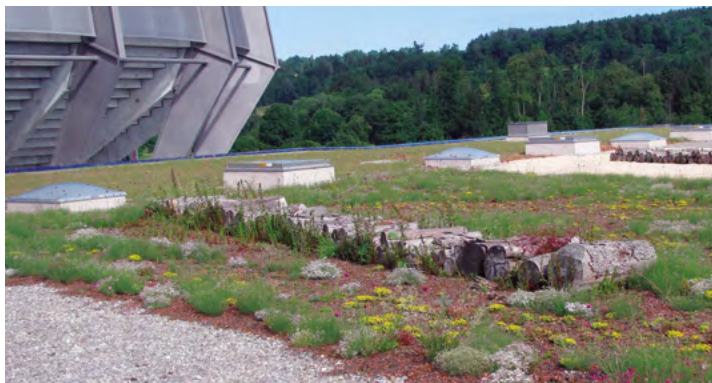
© Stadt St.Gallen, Dachbegrünung
