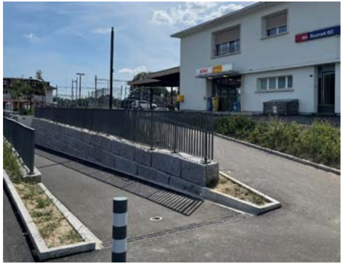
Der neue Zugang zu den Perronanlagen
