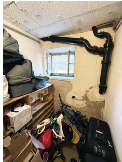
Abb. 7: Küche mit Kochherd und Oberschränken | Abb. 8: Kellerraum mit Abwasserleitung und abgeplatzten Wänden gegen Erdreich
