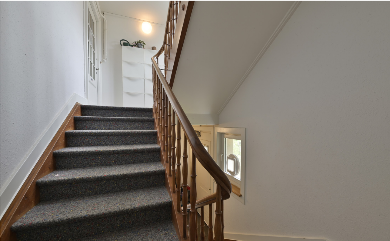
Hagenacherstrasse 24 | Ansicht des Treppenhauses | vestigia 20.06.2024
