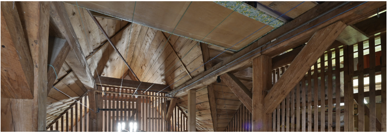
Hagenacherstrasse 24 | Ansicht des Dachwerks | vestigia 20.06.2024
