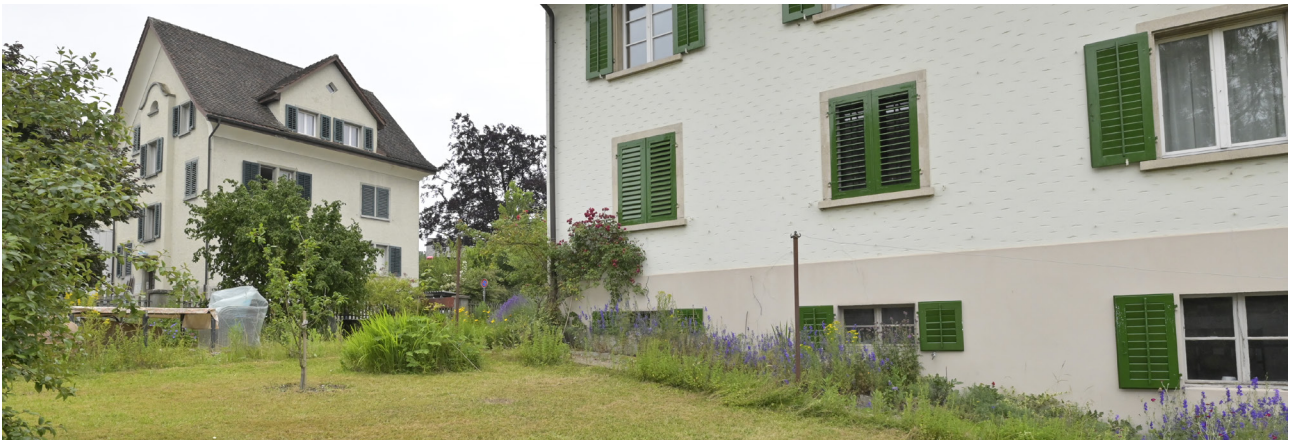
Hagenacherstrasse 24 | Detailansicht der Südfassade mit Garten | vestigia 20.06.2024
