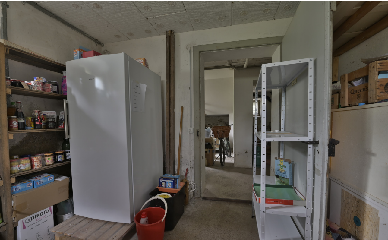
Hagenacherstrasse 24 | Ansicht des Kellergeschosses | vestigia 20.06.2024
