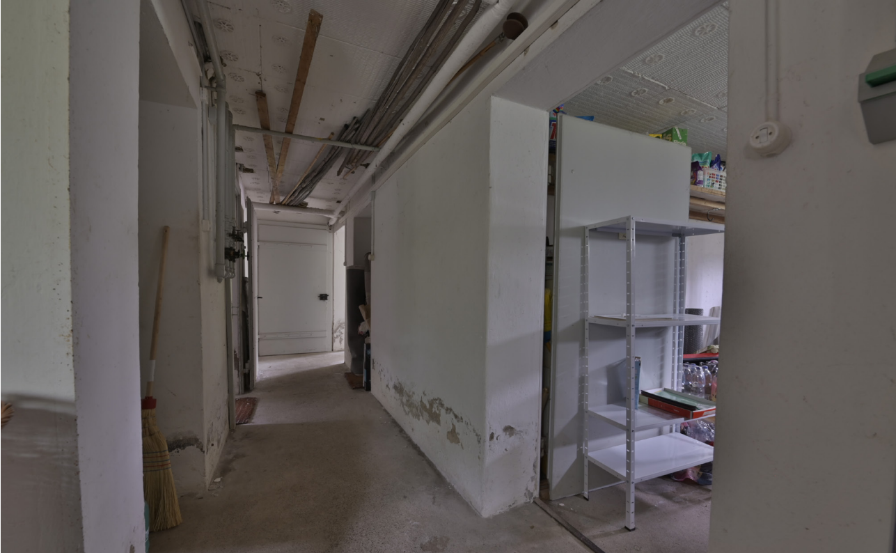
Hagenacherstrasse 24 | Ansicht des Kellergeschosses | vestigia 20.06.2024
