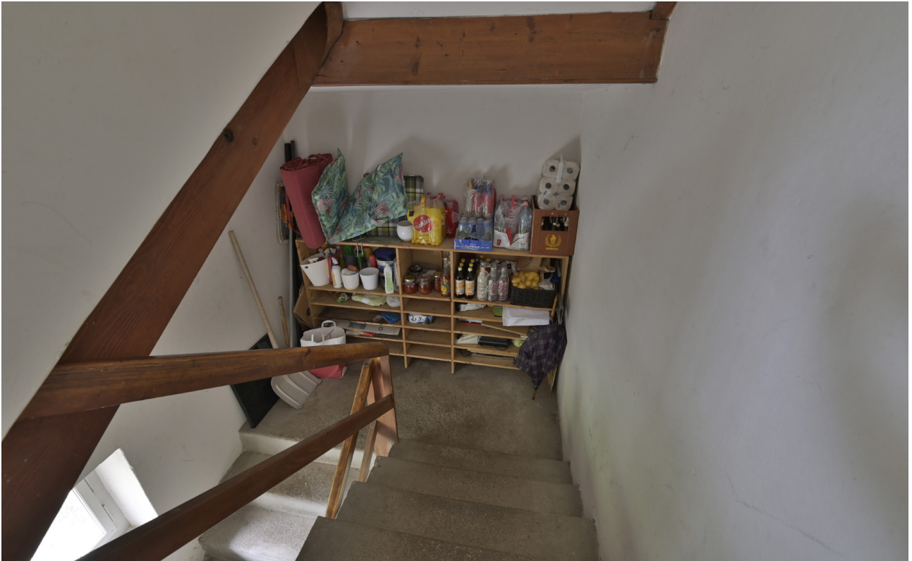
Hagenacherstrasse 24 | Ansicht des Treppenabgangs ins Kellergeschoss | vestigia 20.06.2024
