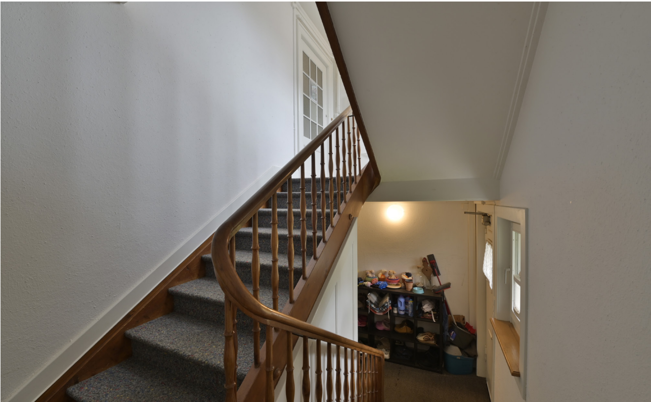
Hagenacherstrasse 24 | Ansicht des Treppenhauses | vestigia 20.06.2024
