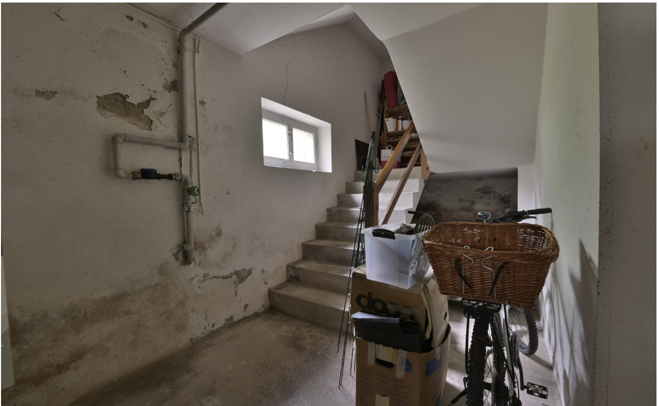
Hagenacherstrasse 24 | Ansicht des Kellergeschosses | vestigia 20.06.2024
