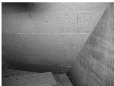
Unterer Konus mit wasserdichter Styropor-Isolation (Grundwasser)
