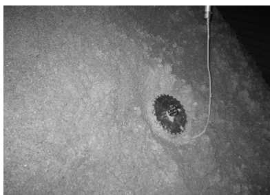
Abschlusskonus mit speziell aufgespritzter Zellulose-Isolation
