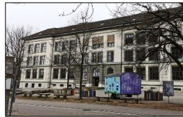
Dachausbau Schulhaus Emmersberg
