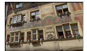
Sanierung Verwaltungsliegenschaft Käfig
