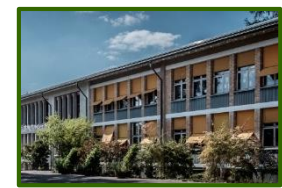
Schulhaus Kreuzgut, Erweiterung und Sanierung
