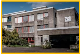
Schulhaus Gräfler, Gesamtsanierung Haustechnik
