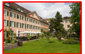
Erweiterung und Sanierung Alterszentren
