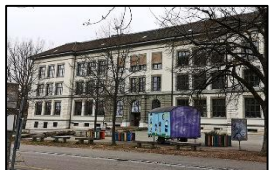
Dachausbau Schulhaus Emmersberg
