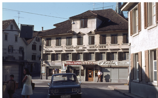
Der Gasthof «Hirschen» an der Ecke Schönenbergstrasse/Zugerstrasse kurz vor dem Abbruch 1975. Das Bild aus der Diasammlung Schoch illustrierte Wädenswil vor 50 Jahren im Jahrbuch der Stadt Wädenswil. Foto: Albert Schoch, Dokumentationsstelle Oberer Zürichsee
