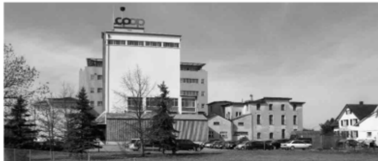
Abb. 9: Zuckersilo, Lagergebäude mit Siloturm, zum Teil Sichtbackstein, 1955–57
