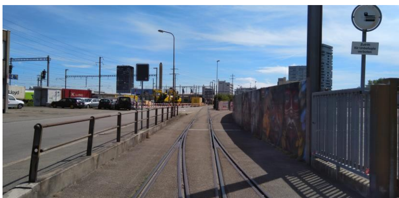
Abbildung 11 Güteranschlussgleis im nördlichen Bereich zur Güterstrasse, Blick gegen Osten
