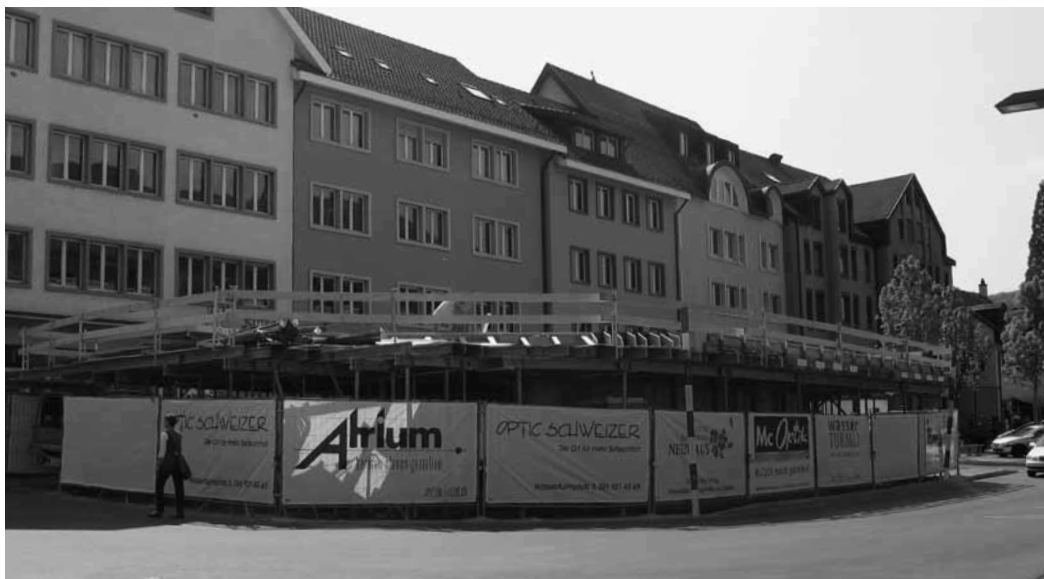
Die Höhe ist bereits erreicht. Noch in diesem Monat können die Schaufenster montiert werden.
