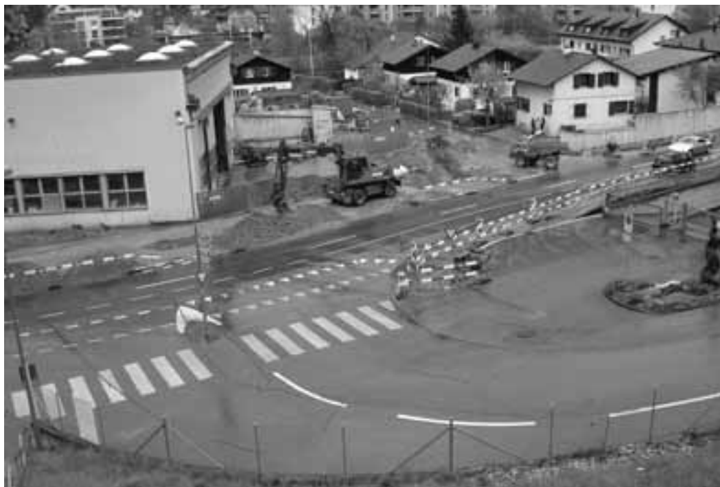
Was nach einer grösseren Baustelle aussieht, ist der Ausbau der Kreuzung Rosenstrasse-Nonnenbodenweg. Foto: Beat Martin
