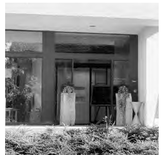
Eingang 2: Befindet sich im Erweiterungsbau und führt ins Café Restaurant und zum Mehrzweckraum. Selbstverständlich sind alle Häuser intern miteinander verbunden und durch eine gute Orientierungshilfe findet man sich gut zurecht.
