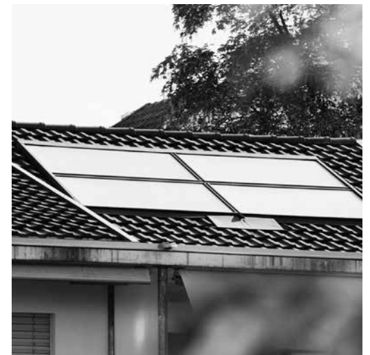
Fotos: Gerry Nitsch/Das Gebäudeprogramm
