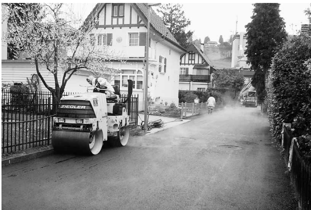
Erneuerung Strassenbelag Ringwaldstrasse
