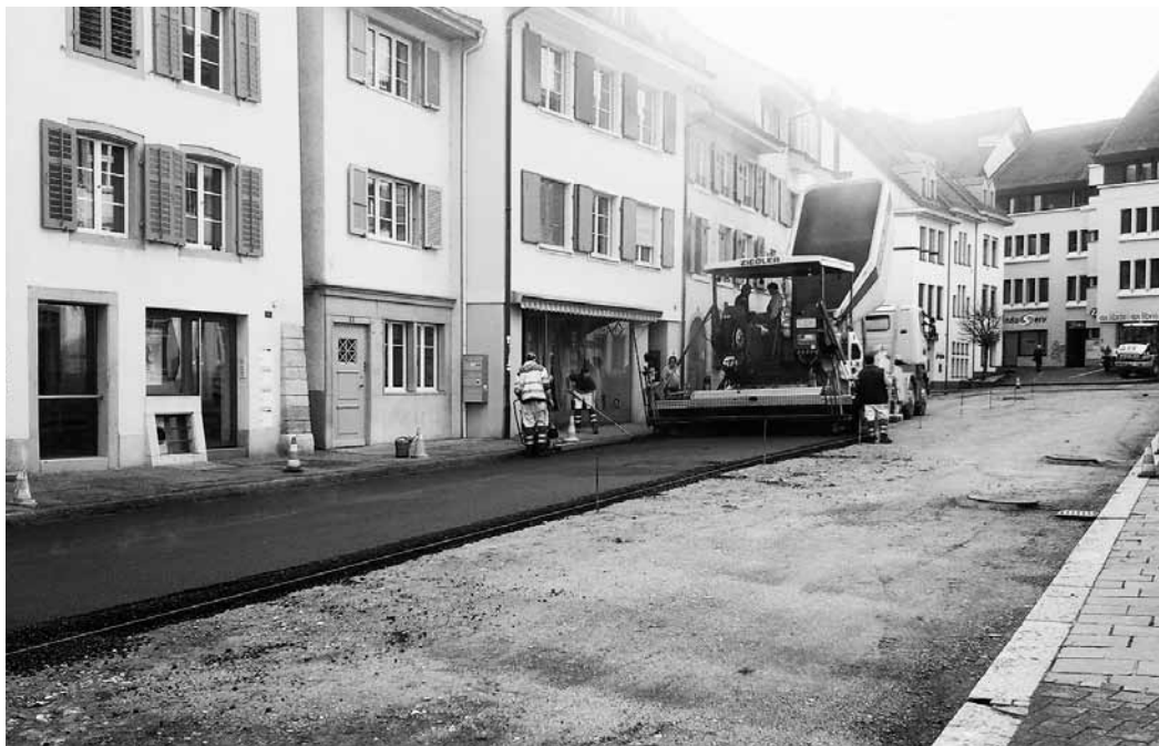
Einbau des neuen Strassenbelages
