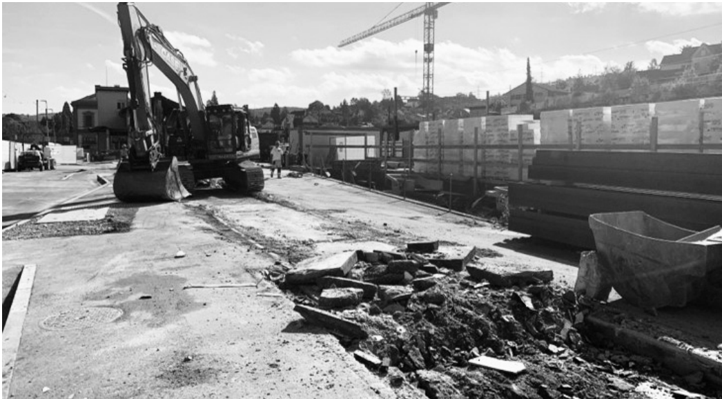
Baustart der unterirdischen Velostation.
