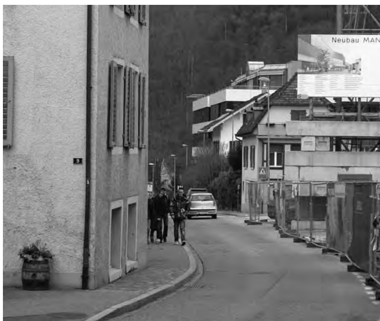
Die Strassensanierung und die Platzgestaltung vor dem Neubau gehen Hand in Hand mit Manor. Gleichzeitig wird der Durchgang vom Manor zur Kanonengasse neu gestaltet.
