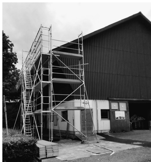
Gerüst am Ökonomiegebäude vom Sichternhof für Montage von Solarpanels
