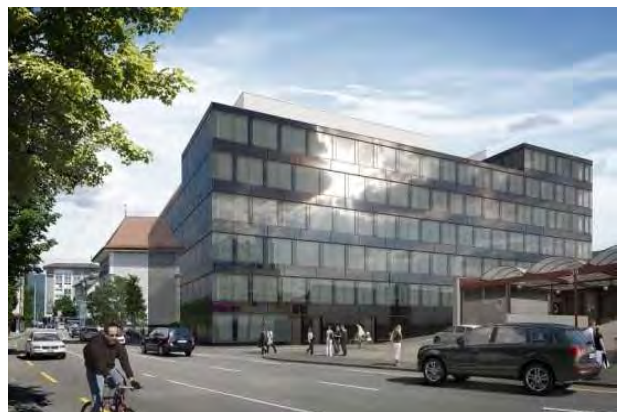
Businesscenter ENERGY, Hauptsitz von SBB Cargo
