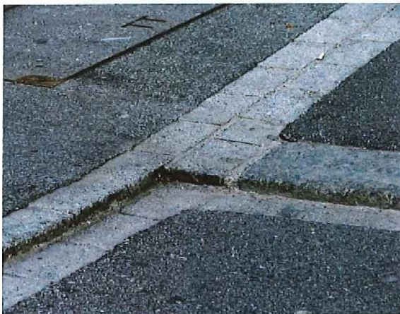
Detailansicht Trottoir bei Mägli
