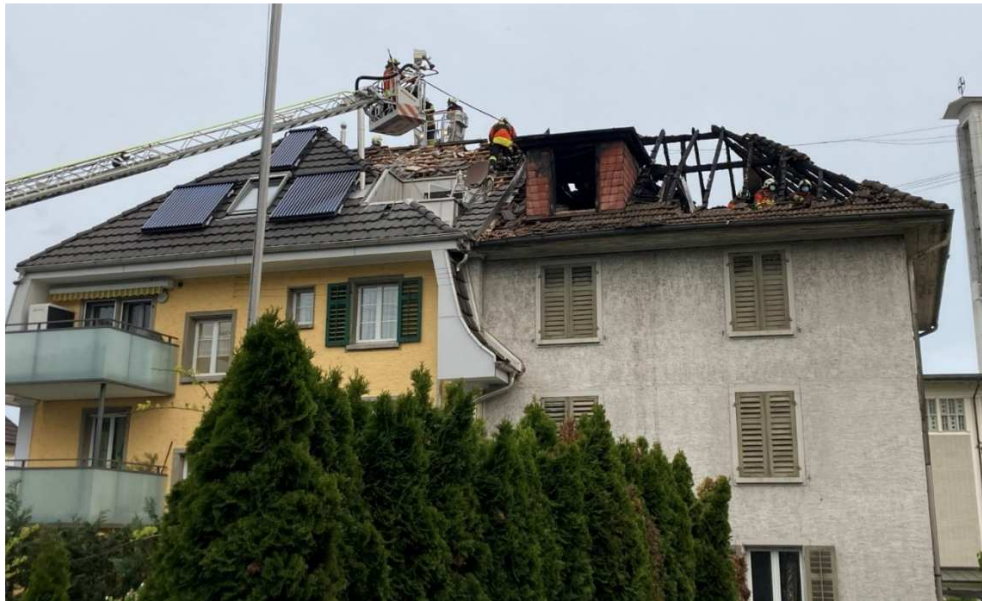
Einsatz bei einem Brand an der Kreuzstrasse in Olten
