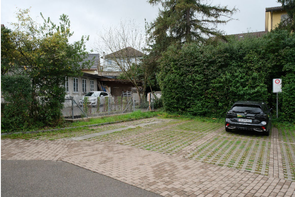
Stellbereich Notstromaggregat u. Einhausung
