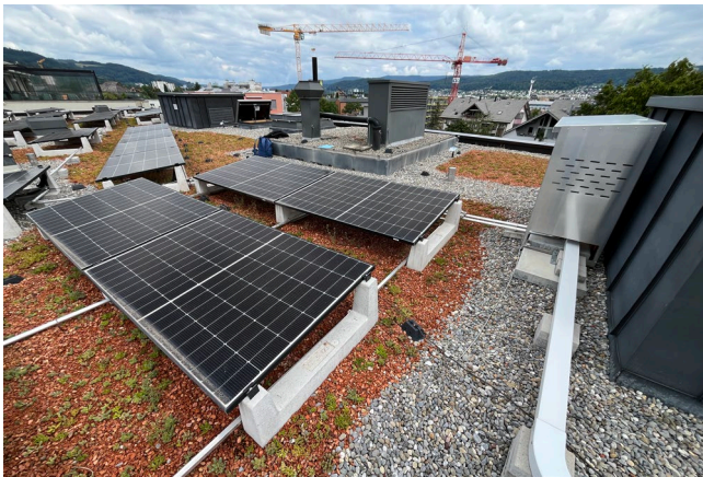
Dachausstieg, Bereich Zugang
