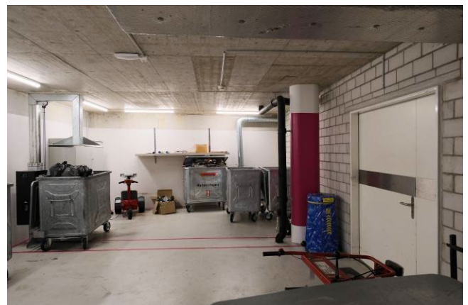
Standort Notstrom wird abgetrennt
