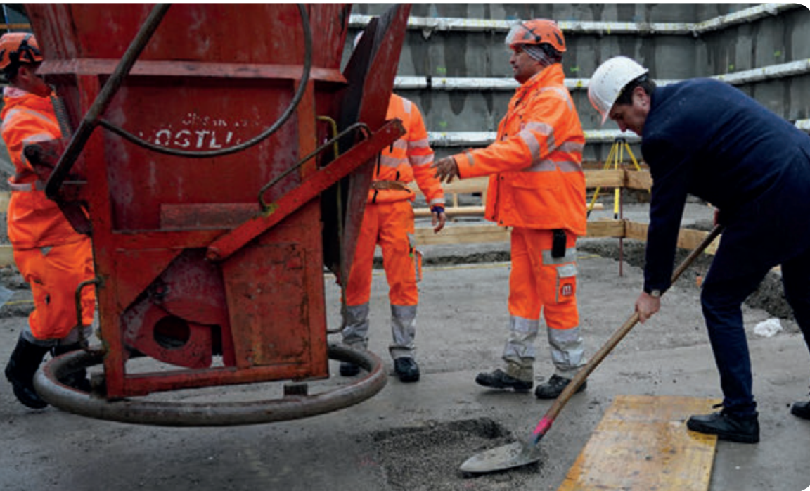
Der Spatenstich beim Investitionsprojekt Schulhaus Wolfsmatt erfolgte 2025.
