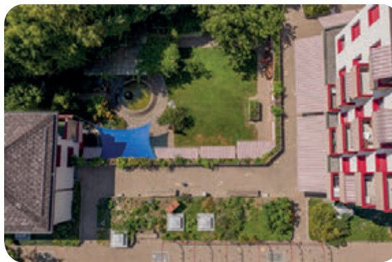
Das Haus Oberdorf (rechts) und das Tageszentrum.
