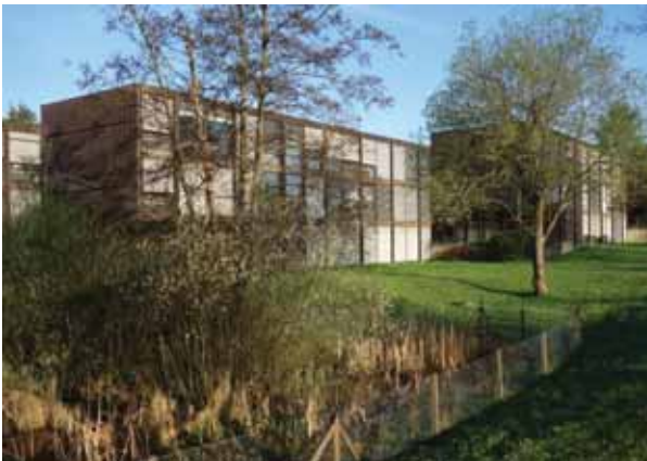
Abbildung 1: Die heutige Schulanlage (Ostfassade)
