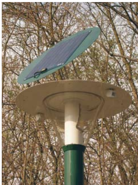
Bild 3: Solarleuchten sind, in Kombination mit Bewegungsmeldern, zur Beleuchtung von Fusswegen sinnvoll. Im Bild eine Versuchsanlage in Zumikon.
