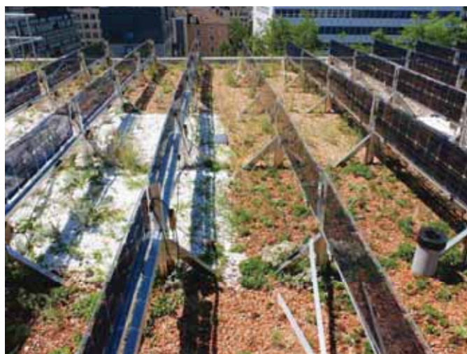
Gründach mit zweiseitigen, vertikalen Solarmodulen auf der Seniorenresidenz Eichgut, Winterthur (Quelle Solarspar)
