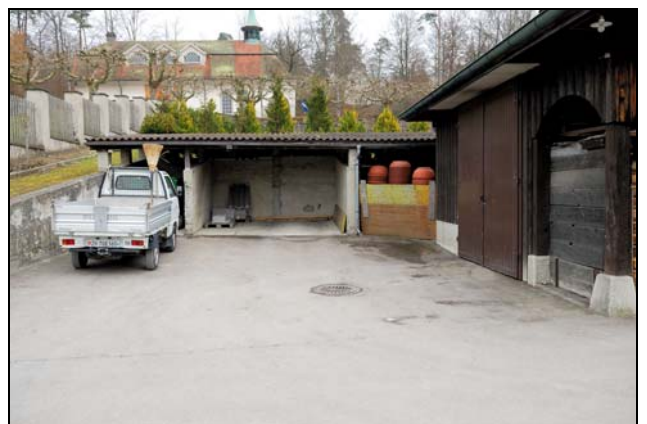
Rechts Einstellraum für Bagger: Umnutzung vorgesehen; hinten: Anbau für Fahrzeuge, Abbruch geplant.
