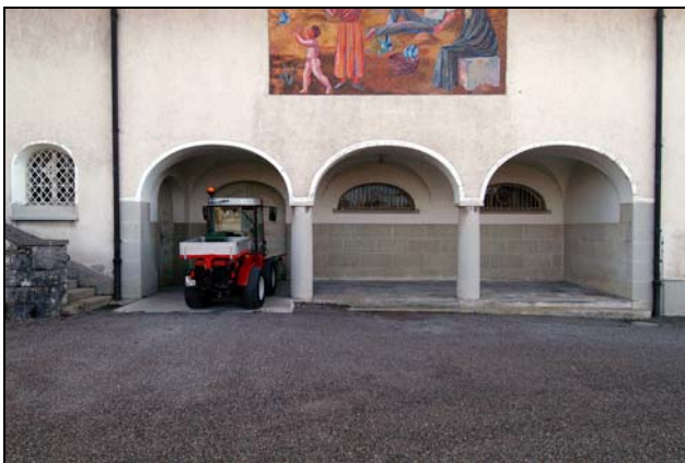
Nebenräume im Erdgeschoss der alten Abdankungskapelle, z.Z. genutzt als Geräteräume; zur Umnutzung vorgesehen.
