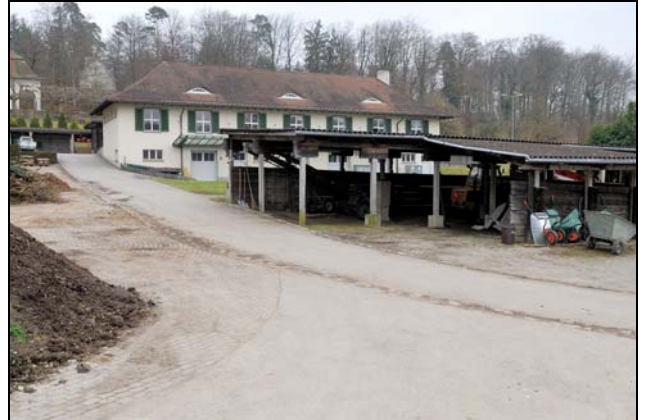
Erdlager und Lagerplatz: Abbruch; Standort neues Werkgebäude.
