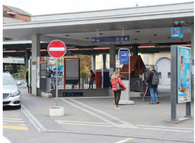
Abbildung 22: Personenunterführung Bahnhof Mitte.
