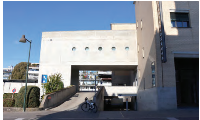
Abbildung 21: Personenunterführung Bahnhof West.
