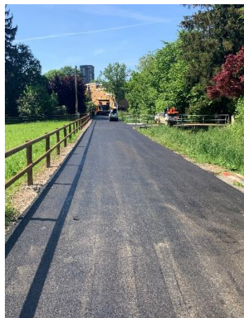
Strasse entlang Furtbach
