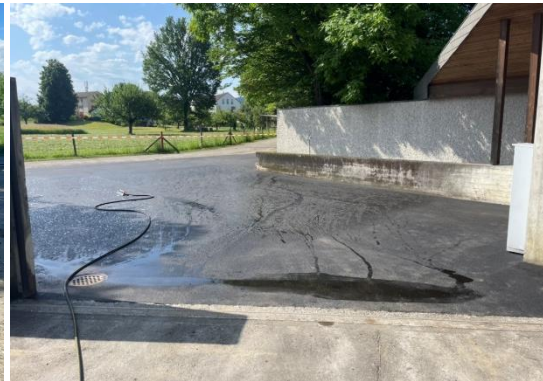
Der fertiggestellte Vorplatz
