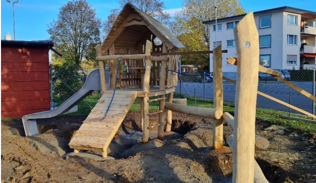
Spielhaus auf Stelzen mit Anbaurutsche und schrägem Kletteraufgang sowie diversen Balancierbalken
