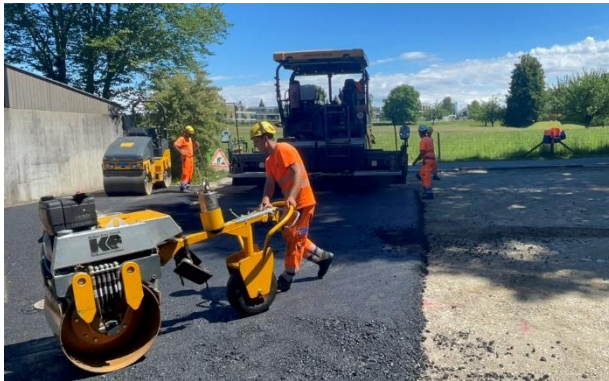
Der Vorplatz während dem Einsetzen des Belags
