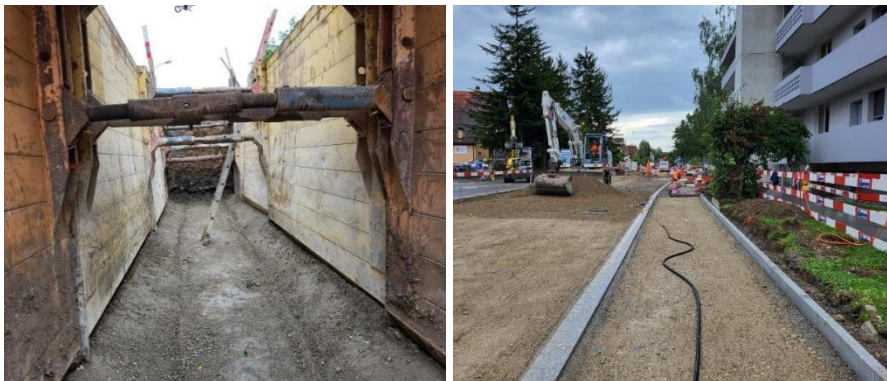
Grabenspriessung für Kanalisation
