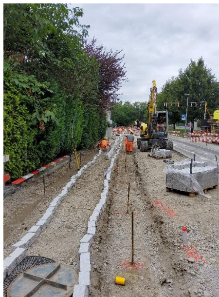
Absteckung für Randabschlüsse und Strassenfundation
