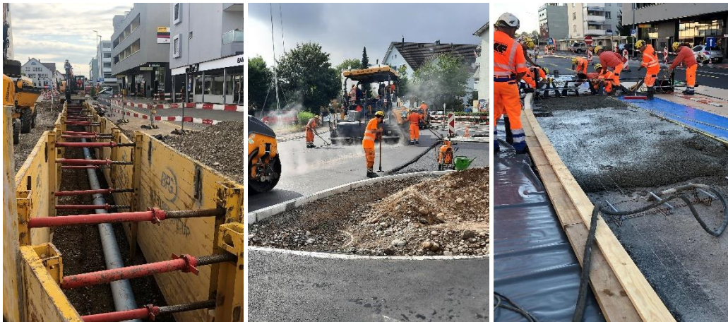
Werkleitungs-, Belags- und Betonarbeiten
