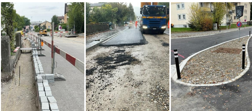
Pflasterung- und Belagsarbeiten sowie neu geschaffene Baumgruben
