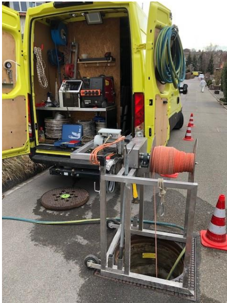
Installation für Inliner
