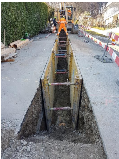
Gesprester Graben für neue Kanalisation
