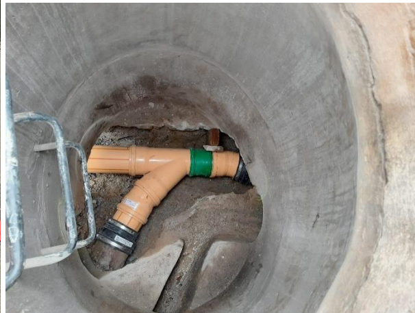
Sanierung von Schachtsohle
