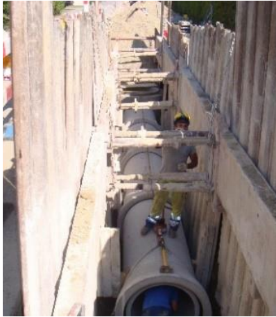
Grabenbau für Kanalisation
