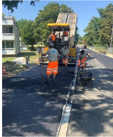
Belagseinbau mit Fertiger
