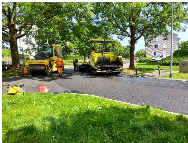
Deckbelagseinbau mit Einbaumaschine (Fertiger)
