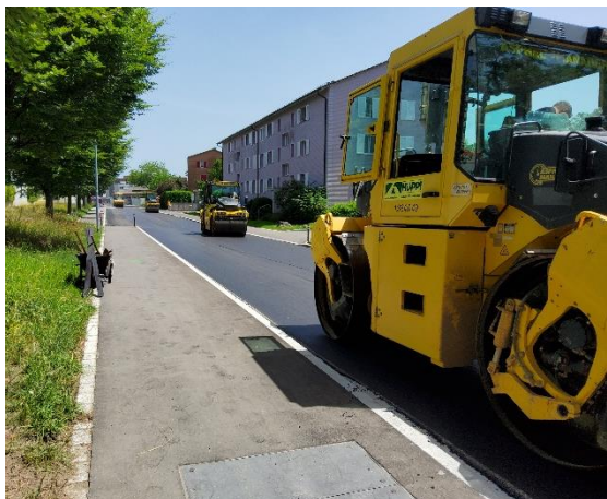
Belagsverdichtung mit Walzen
