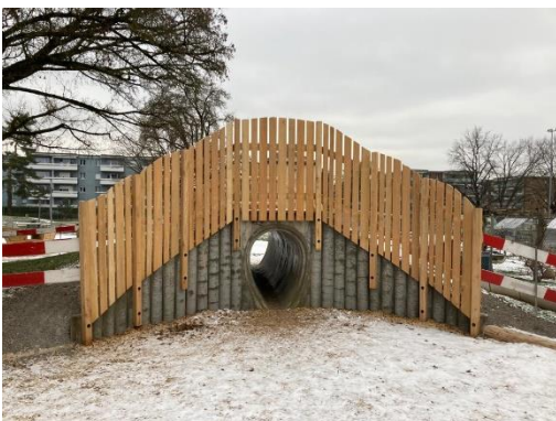
Röhre mit Brüstung
