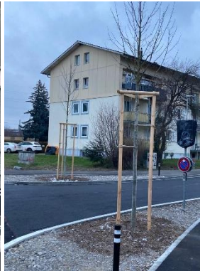
Neue Bergahorne an der Grundstrasse
