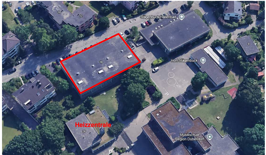
Abbildung: Gebäudeaufnahmen Schulanlage Stägenbuck mit möglichem Wärmepumpen Standort auf Sporthalldach
