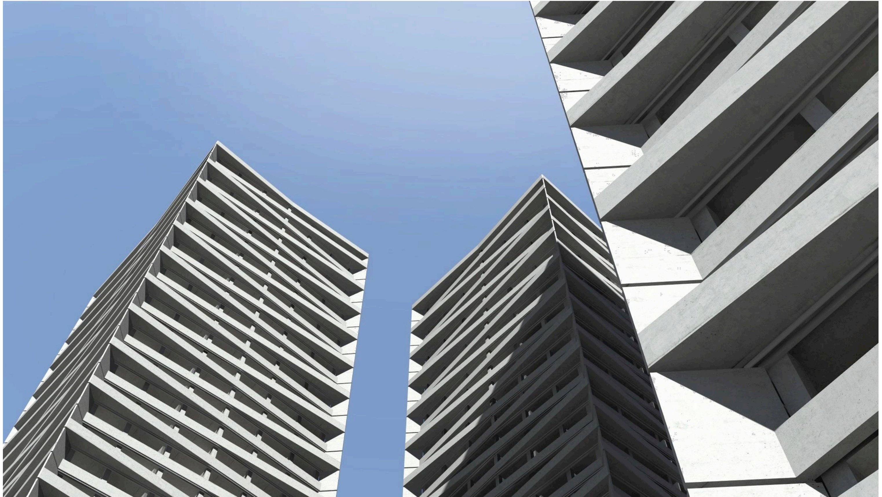
Plastizität der Fassade: Gute Fernwirkung, zweigeschossige, räumlich attraktive äussere Balkone vor den Loggias (Jahreszeitenzimmer) mit Vertikalbezügen nach oben und unten
