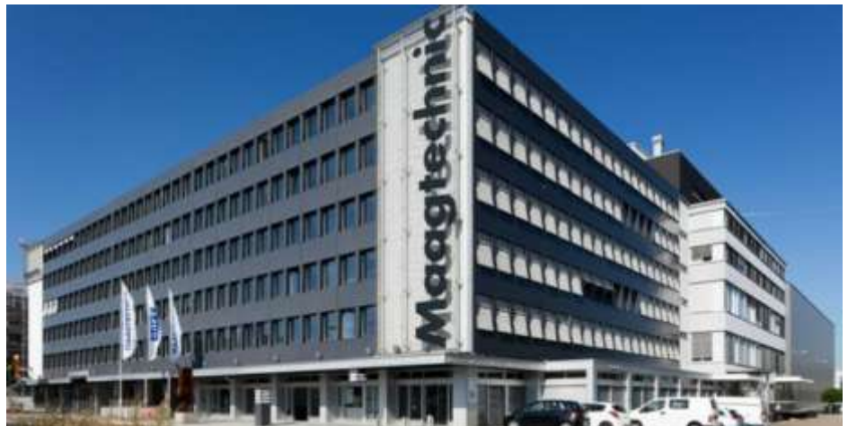
Abbildung 3 Foto Bestand, Ansicht von "Sonnentalstrasse", Quelle: Allreal
