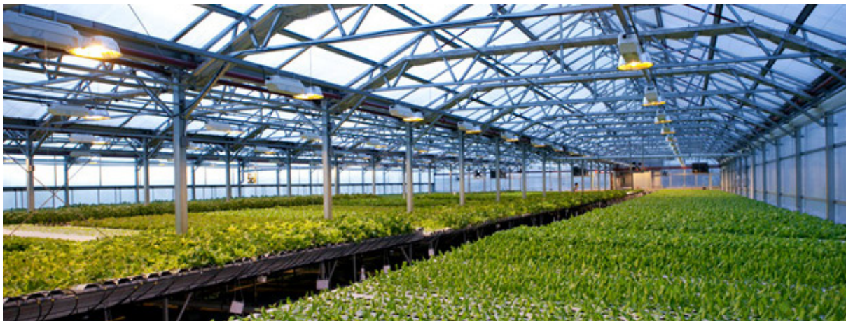
Beispiel: Urban Farm Gewächshaus der Gotham Greens in den USA
