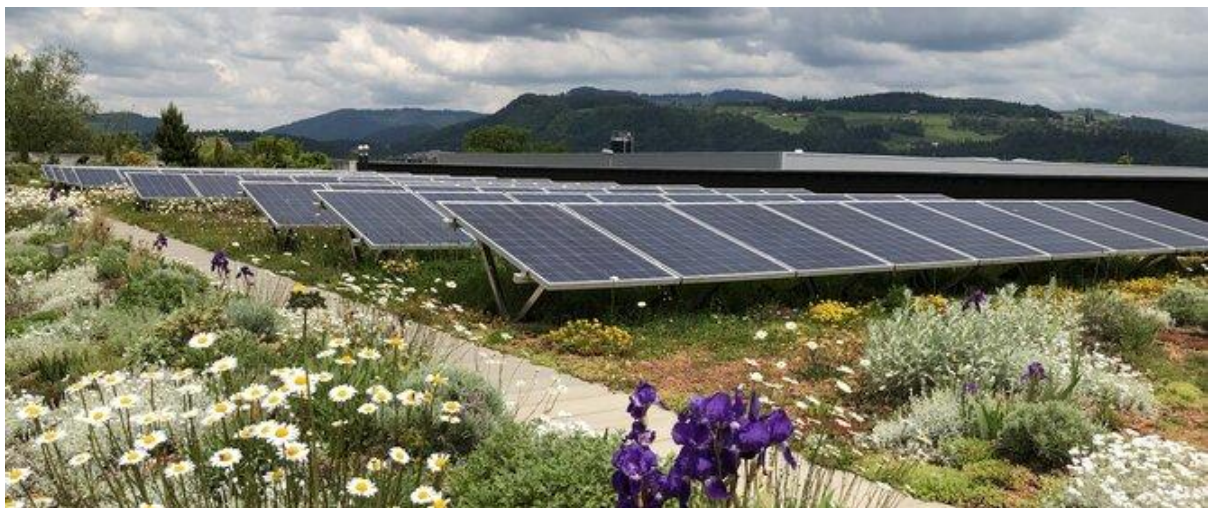
Abb. 30: Dachbegrünung in Kombination mit PV-Anlage (Quelle: Bauenschweiz)
