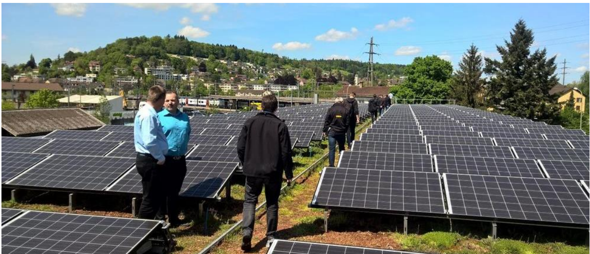
Abbildung 34: Referenzbild Solardach mit extensiver Dachbegrünung (Quelle: a777.ch)
