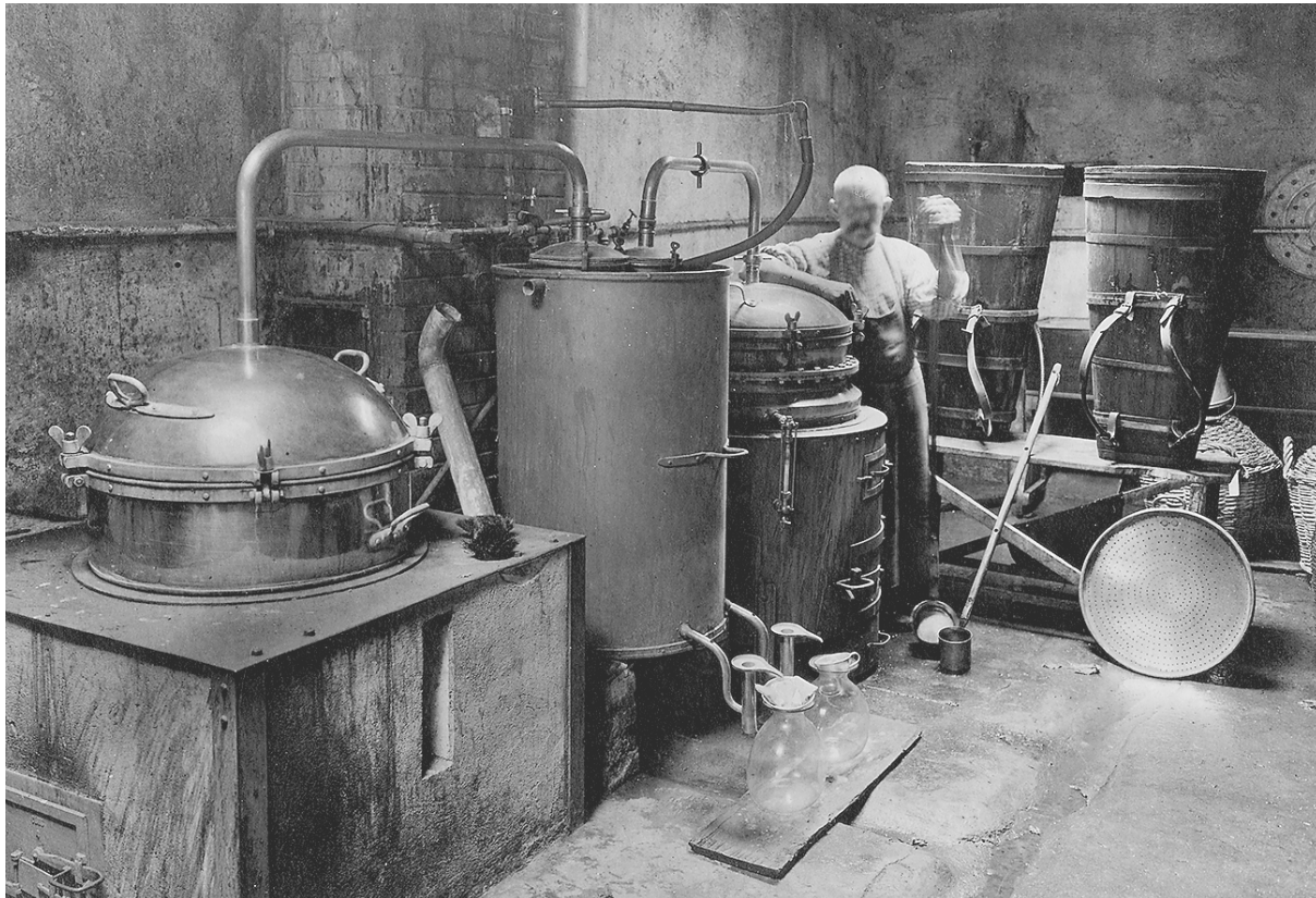
Kirschbrennerei im «Kirsch-Depot» an der Aegeristrasse 40, 1918–1931. (DNS-Transport © Ueli Kleeb)
