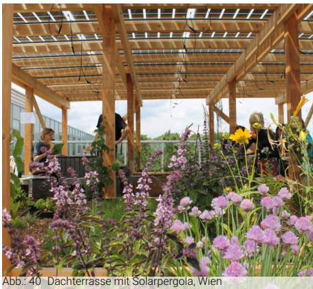
Abb.: 40 Dachterrasse mit Solarpergola, Wien
