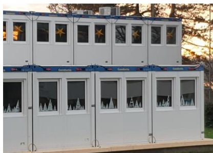
– Abbildung 9 Modulbau Kirchmatt
