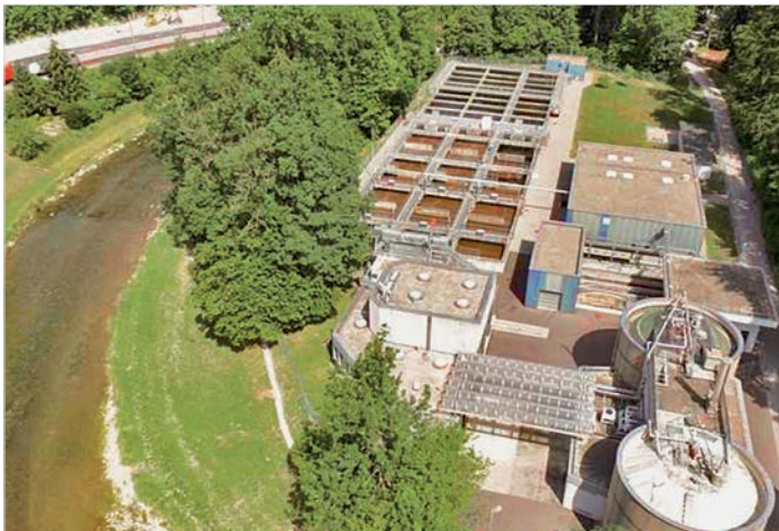
Je mehr Einwohner, umso mehr Abwasser: Die ARA Sihltal testet innovative Methoden.
