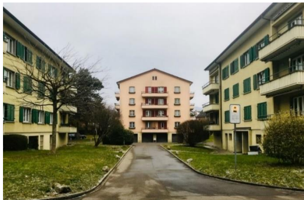
Abbildung 4 Bestehende Bebauung, MBA-Häuser, 2019 (Quelle: Eigene Aufnahme)
