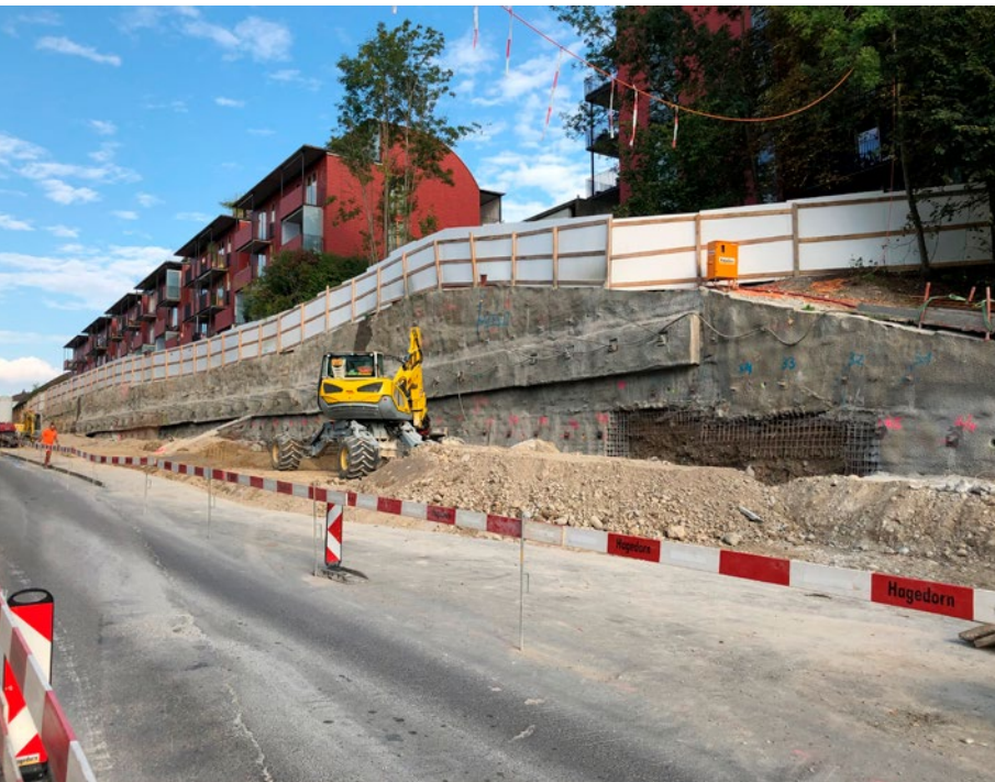
Baugrube für die Stützmauer an der Weststrasse
