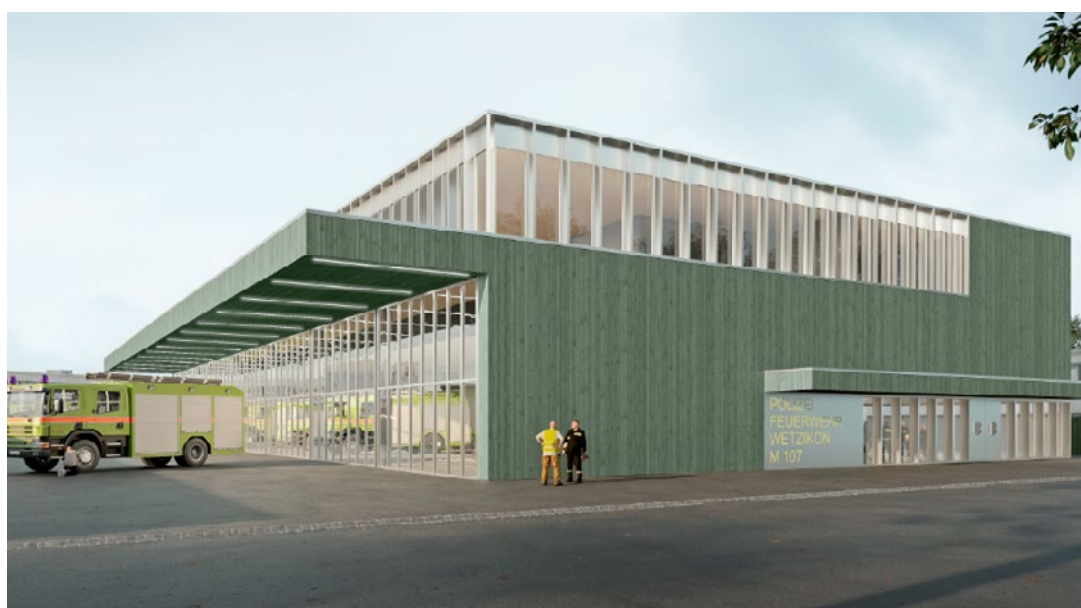
Das neue Feuerwehrgebäude wird auch die Stadtpolizei Wetzikon beheimaten.
