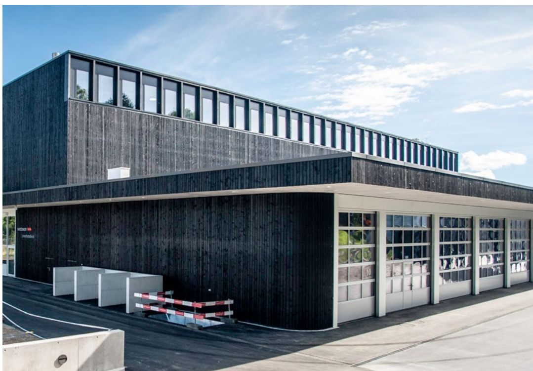
Die letzten Arbeiten am neuen Werkhof fanden 2021 statt, ehe im kommenden Jahr die Stadtwerke und der Unterhaltsdienst einziehen werden.
