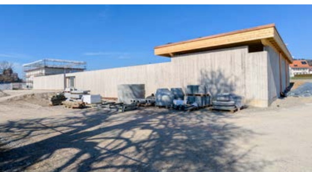
Die Gesamtsanierung und Erweiterung des Friedhofs Wetzikon schreitet planmässig voran.
