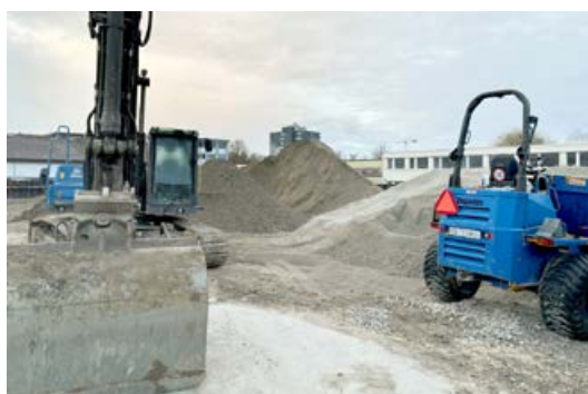
Vor Ende 2024 begannen die Bauarbeiten für das neue Feuerwehr-, Polizei- und Zivilschutzgebäude.
