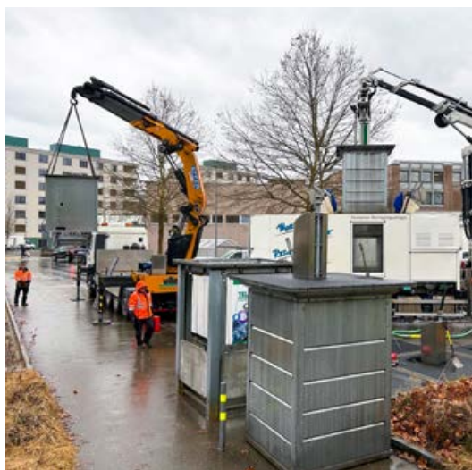
Quartiersammelstelle Pappelstrasse während der Reinigung und dem Einbau des neuen Unterflurcontainers für Textilien.
