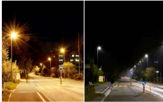
Vorher und nachher: Mit den neuen LED-Strassenlaternen wird Licht nur dann erzeugt, wenn es benötigt wird.
