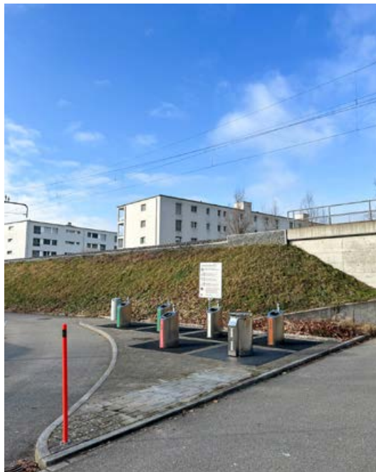
Quartiersammelstelle Pappelstrasse: links vor dem Umbau, Bild darunter nach dem Umbau.
