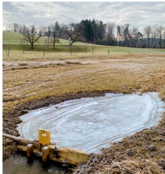
Mit regulierbaren Stauvorrichtungen entstanden im Ried Eichholz zwei Teiche.
