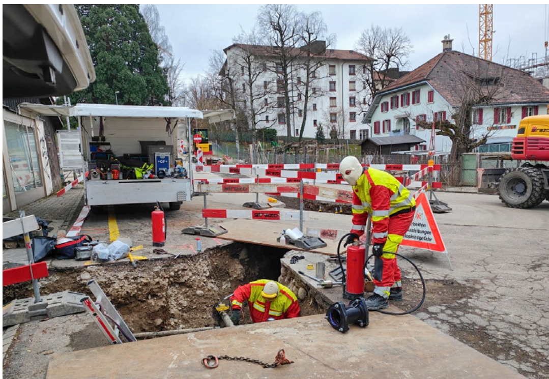
Bei Arbeiten an Gasleitungen gelten für die Mitarbeitenden höchste Vorsicht und Sicherheitsmassnahmen.
