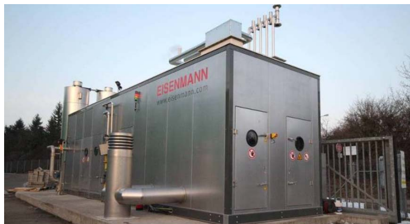
Abbildung 1: Anlagenbeispiel einer Biogasaufbereitung im Membranverfahren ( www.eisenmann.com )
