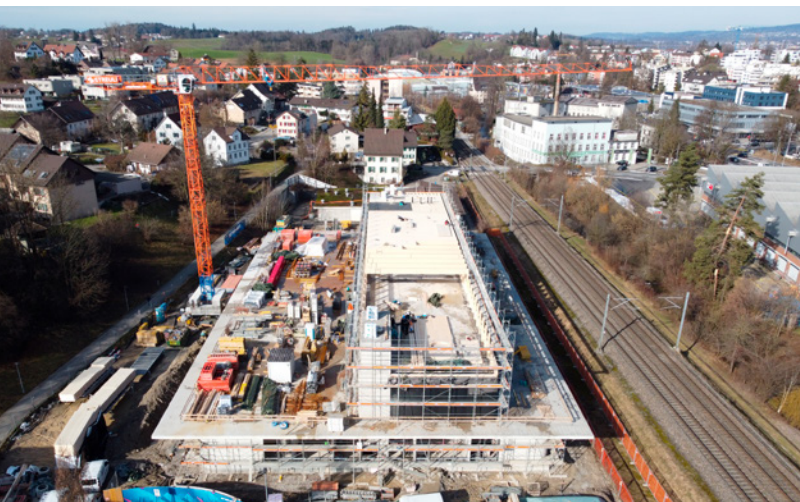
Bis Ende 2020 steht der Rohbau für den Neubau des Werkhofs für die Stadtwerke und den Unterhaltsdienst.
