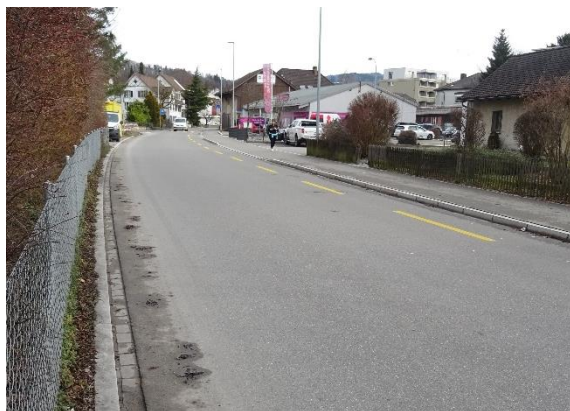
Abbildung 9: Stationsstrasse «Ost», Blick in Richtung Bahnhofstrasse
