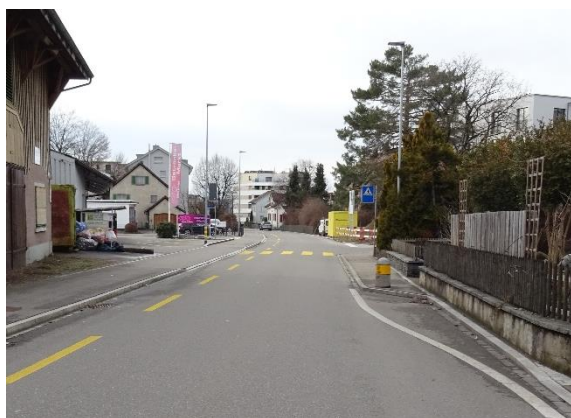
Abbildung 6: Seitliche Einengungen entlang Stationsstrasse «Ost»
