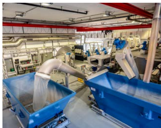
Einblick in die mechanische Reinigung der Abwasserreinigungsanlage (ARA) Flos.
