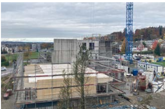
Bauarbeiten beim Primarschulhaus Walenbach
