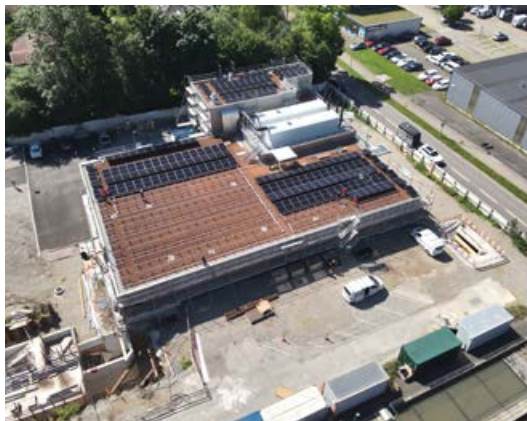
Die neue Photovoltaik-Anlage auf dem Gebäude der Sandfang- und Vorklärbecken, die seit Juli 2025 mit rund 300 Modulen Strom produziert.
