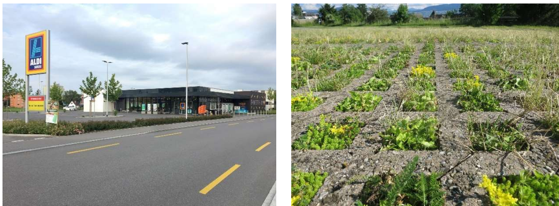
Abbildung 35: Versiegelter Parkplatz im Industriegebiet an der Motorenstrasse (links) und durchlässiger Parkplatzbelag mit Rasengittersteinen und artenreicher Vegetation als Referenz (rechts).
