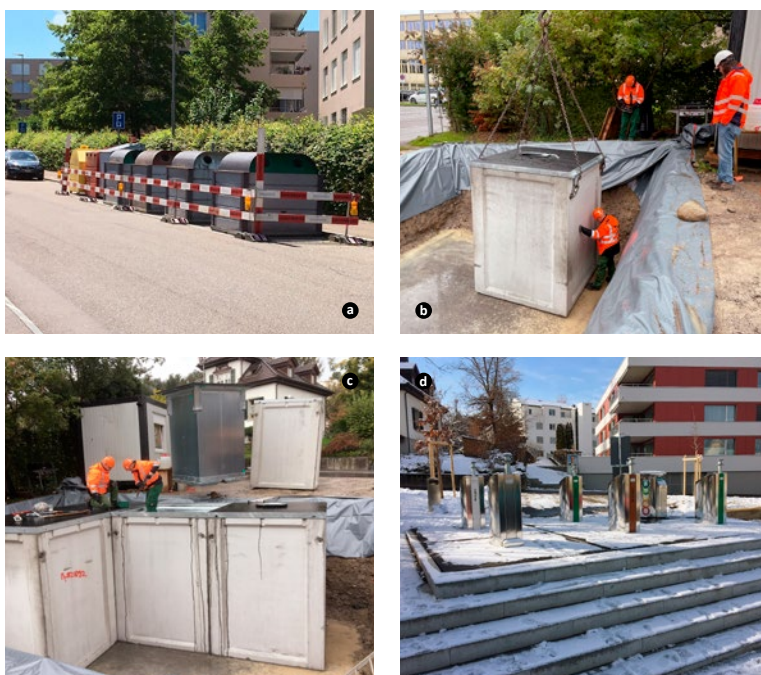
a Provisorium an der Guyer-Zeller-Strasse b Versetzen des ersten Unterflurcontainers c Ausrichten der Betonelemente d Fertige Unterflursammelstelle
