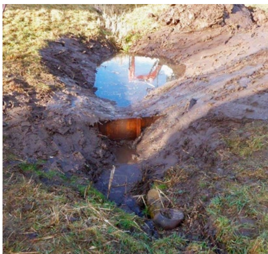
Die neu eingebaute Spundwand staut den Entwässerungsgraben und lässt so ein kleines Stillgewässer entstehen.
