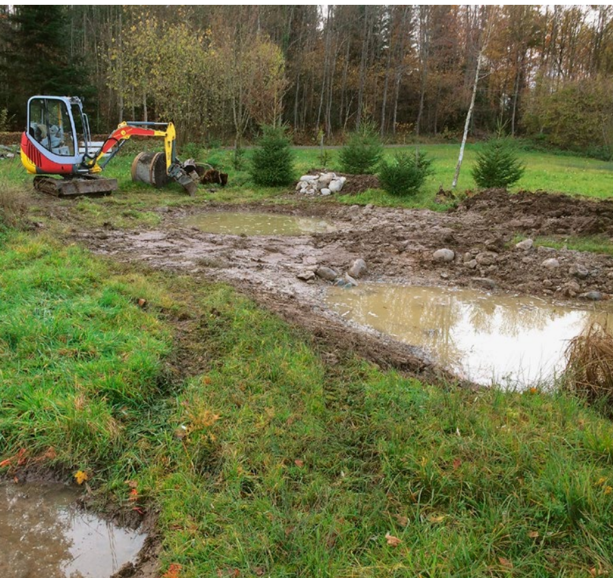
Bau der Kleingewässer beim Umschlagplatz Moosholz im November 2022.
