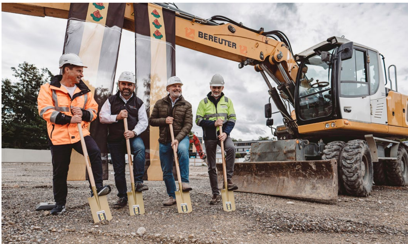
Mit dem Spatenstich für den Ausbau der Abwasserreinigungsanlage Flos beginnt die erste Bauetappe.
