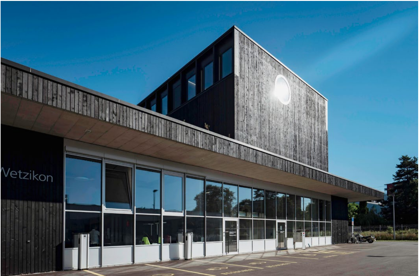
Werkhof der Stadtwerke und des Unterhaltsdiensts der Stadt Wetzikon
